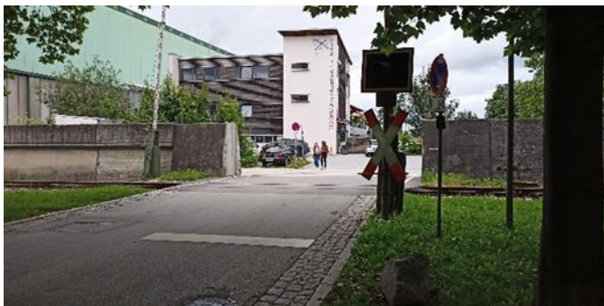
Abb. 99. Hochwasserschutzanlage in Deggendorf 17
