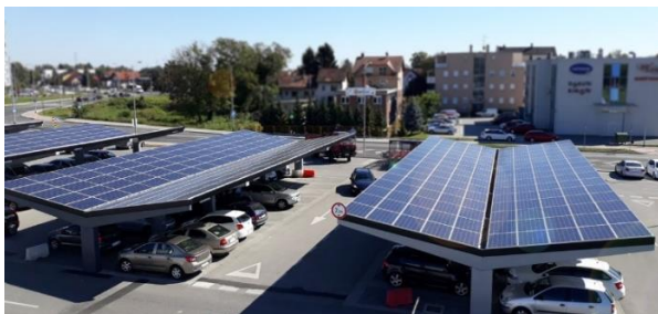
Abb. 116. Beispiel Überstellung von Parkplätzen mit PV-Anlagen 32
