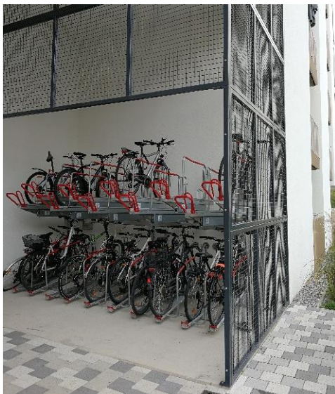
Abb. 124. Überdachte Fahrradabstellmöglichkeit direkt am Wohngebäude 40
