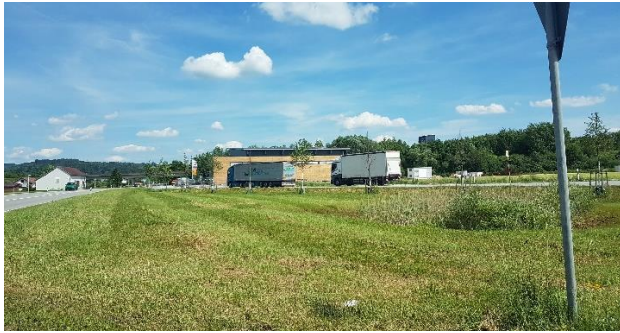
Abb. 119. Retentionsfläche bei Fischerdorf 35
