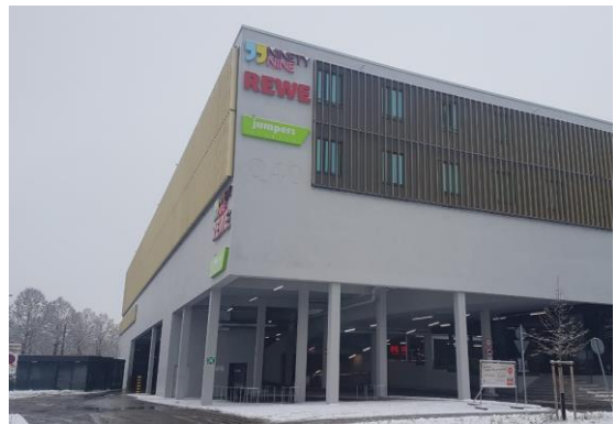
Abb. 118. Parkhaus über REWE-Supermarkt am Technologiezentrum Augsburg 34
