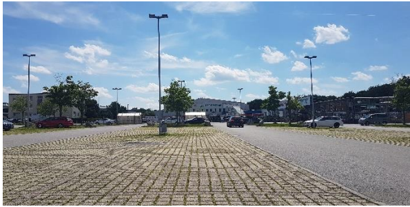
Abb. 114. Gepflasterter Parkplatz im Gewerbegebiet „Land-Au“ mit wasserdurchlässigen Fugen 30
