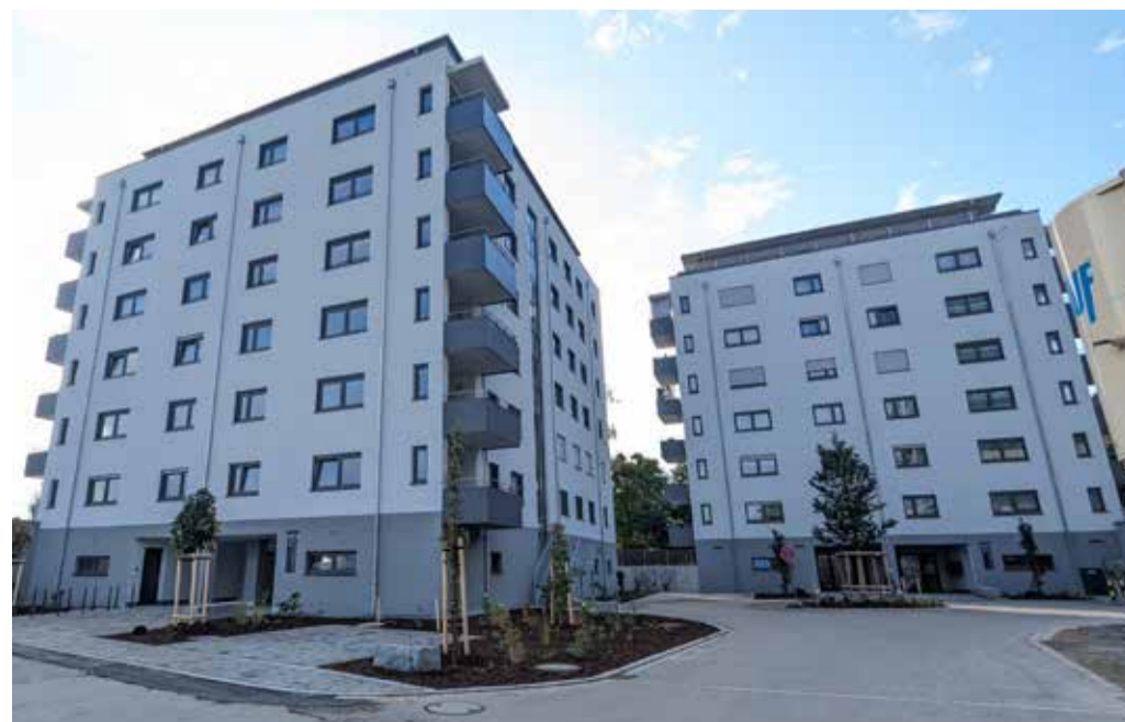
In zwei Bauabschnitten von Juli 2020 bis Oktober 2023 sind zwei Punkthäuser mit insgesamt 66 Wohnungen in der Dr.-Kollmann-Straße 23 und 25 entstanden.
