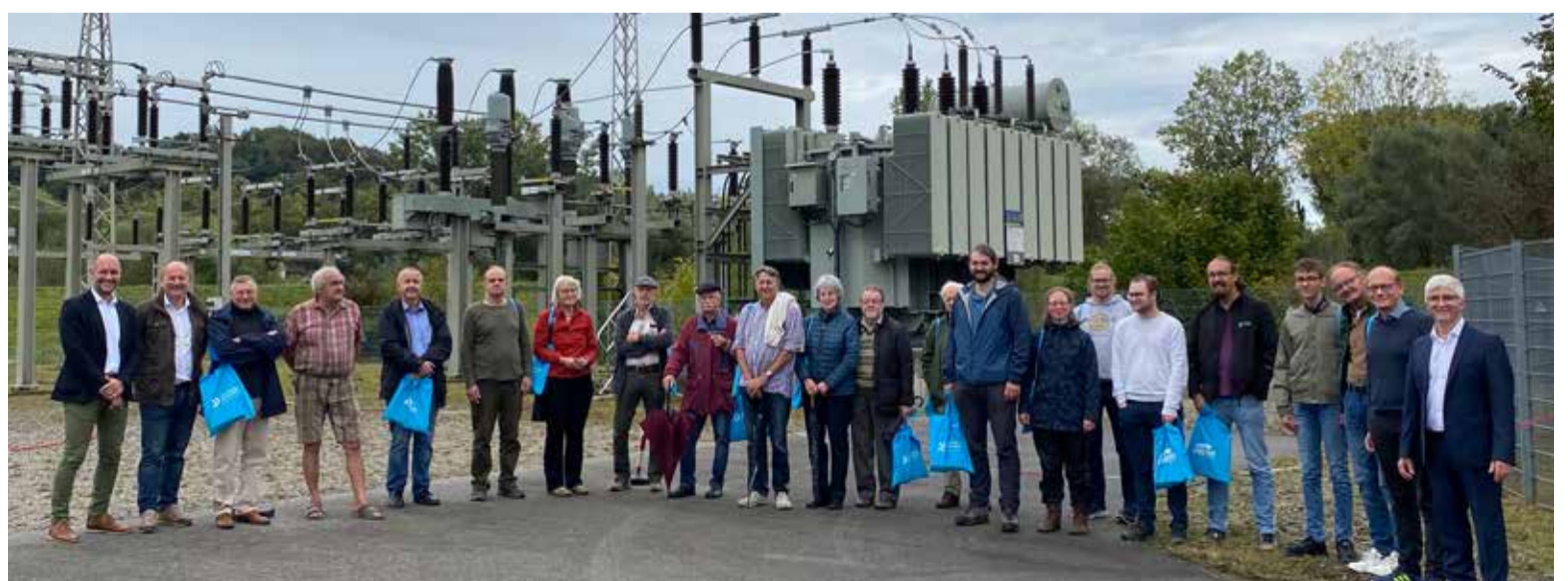
Geschäftsführer Alexander Springer (1. v. r.) und der Technische Leiter, Gerhard Kuchler (2. v. l.) geben Einblicke in die Funktionsweise des Umspannwerks Fischerdorf.
